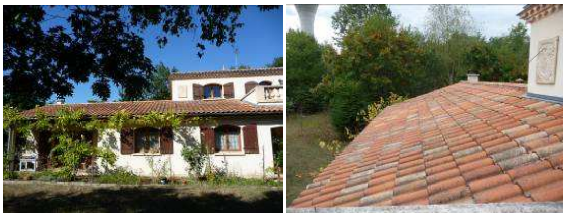
Mon toit avant l'installation
